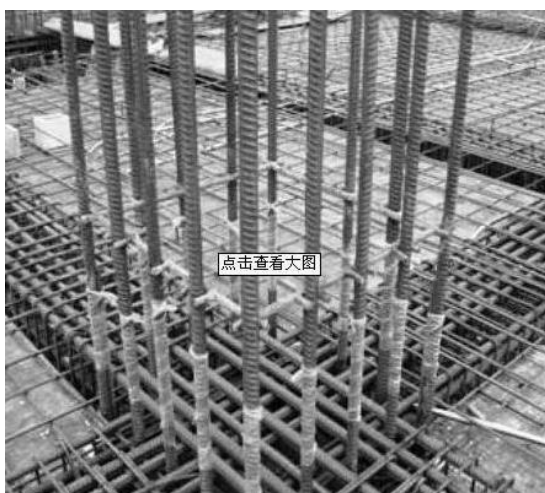
控制竖向钢筋间距的定位筋
