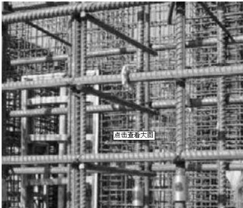
剪力墙设置竖向梯子筋来控制水平筋间距
