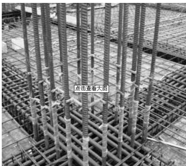
控制竖向钢筋间距的定位筋
