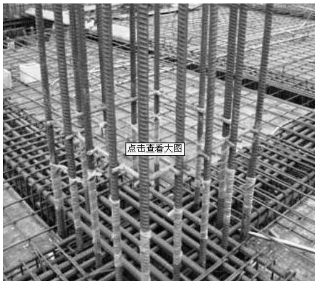
控制竖向钢筋间距的定位筋
