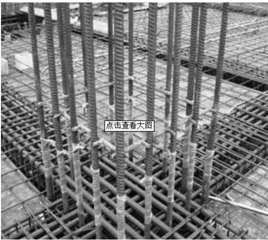
控制竖向钢筋间距的定位筋
