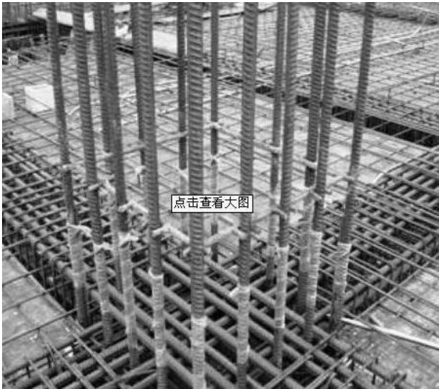
控制竖向钢筋间距的定位筋
