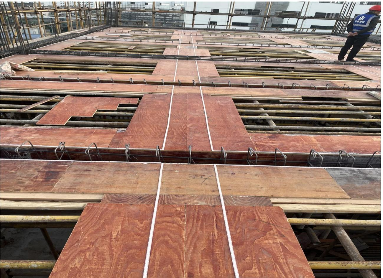
叠合板底部模板面上在PC预制构件与现浇板带、现浇梁接缝处粘贴双面胶。
