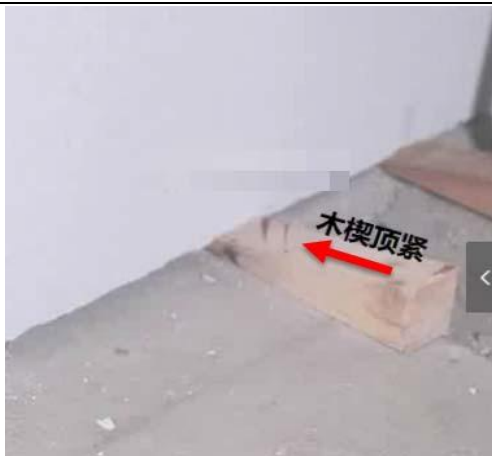
墙板上下端侧面用木楔顶紧墙板
