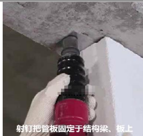
顶部配件用射钉固定于混凝土结构上
